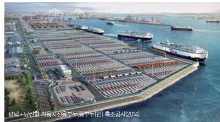
평택·당진항 자동차전용부두(동부두1번) 축조공사(2014)
