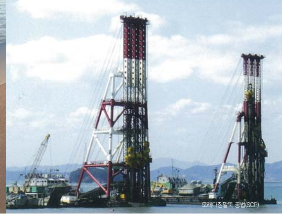
모래다짐말뚝 공법(SCP)
