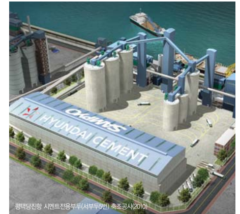
평택당진항 시멘트전용부두(서부두5번) 축조공사(2010)
